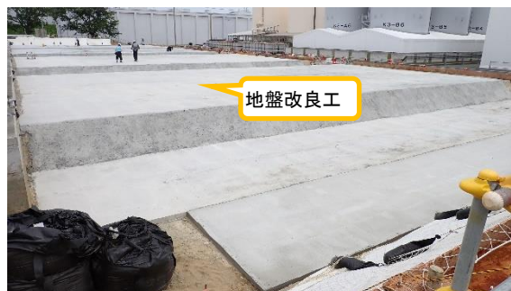
(写真1-2) 敷地東側拡張工事の状況 (南西側から撮影) (令和6年6月14日撮影)
