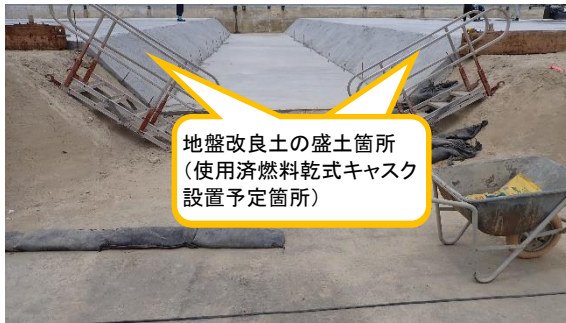
(写真2) 地盤改良工の施工状況 (東側から撮影)
