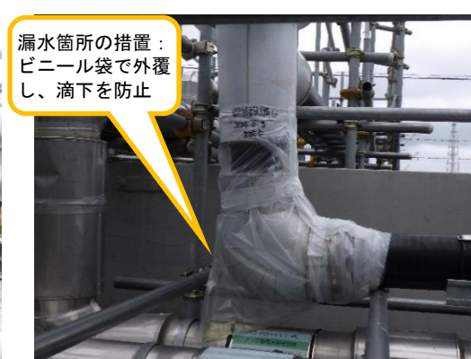
(写真1②) 漏えい箇所の措置状況
