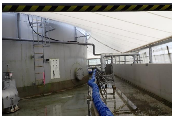
(写真3①) G4南タンクエリア内
