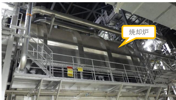
(写真 1) 焼却炉外観
