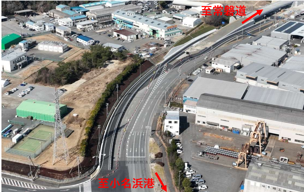
【写真①】 泉町下川地内
