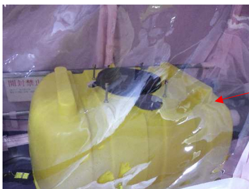
受入タンク設置中の写真
