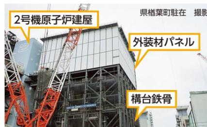
2号機の南側構台設置の様子
