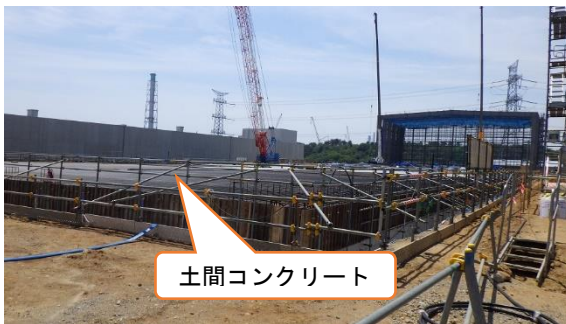
(写真4-2) 固体廃棄物貯蔵庫第10棟（C棟） 土間コンクリートの打設状況 ※作業停止中
