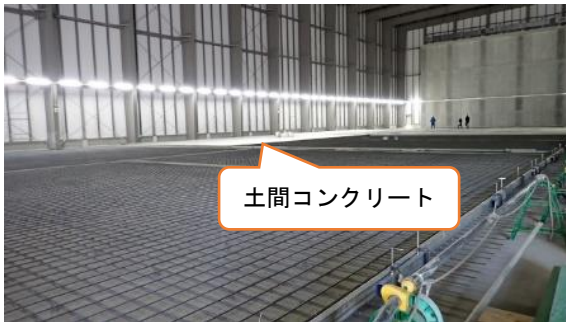
(写真4-1) 固体廃棄物貯蔵庫第10棟（B棟） 土間コンクリートの打設状況 ※作業停止中
