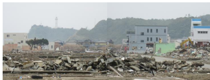
薄磯地区被災状況
