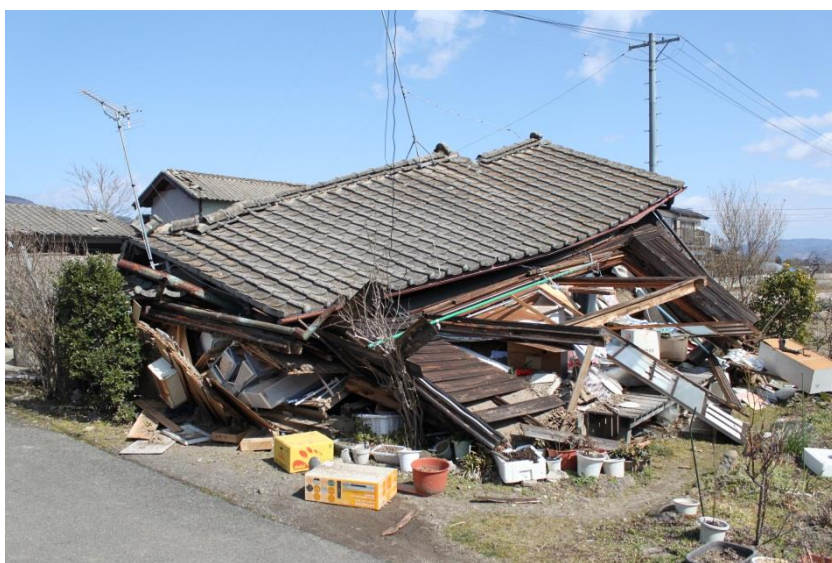
倒壊した町営住宅
