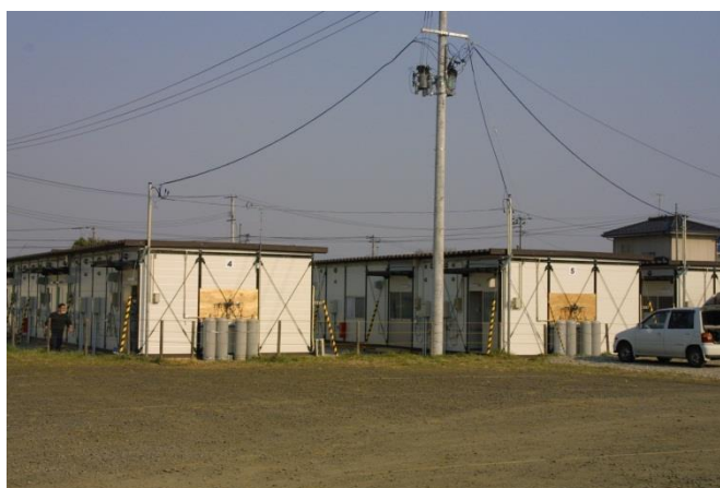
完成した応急仮設住宅
