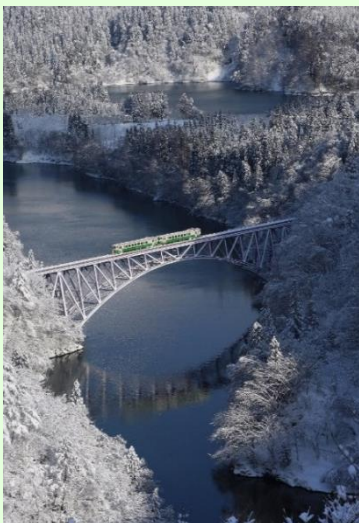
第1只見川橋梁
