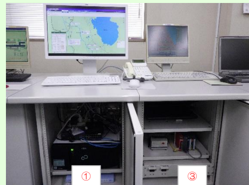
①放流操作装置 ②ファイル装置 ④表示制御装置
