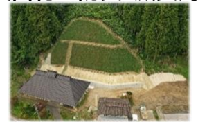
治山施設整備
