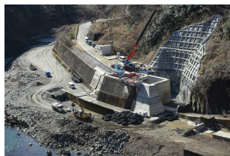
工事の様子（令和6年3月） （建屋解体完了）
