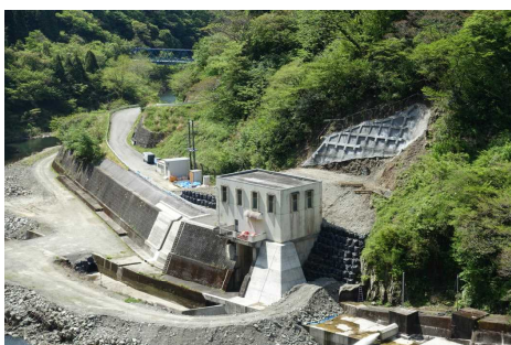
高柴ダム発電所（令和5年4月） （法面工事開始）
