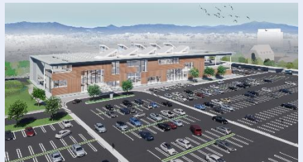
郡山合同庁舎 (工事中)
