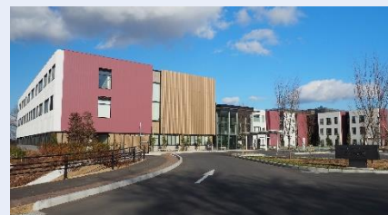
ふくしま医療センターこころの杜 (矢吹町)
