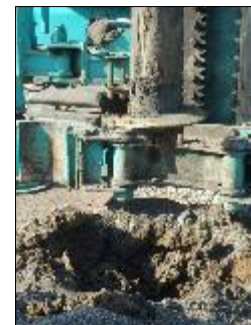
先端部の引き抜き状況
