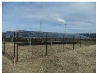
300kw太陽光発電所
