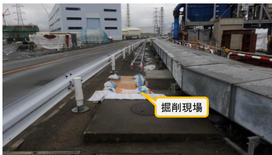
(写真7) 掘削現場の状況
