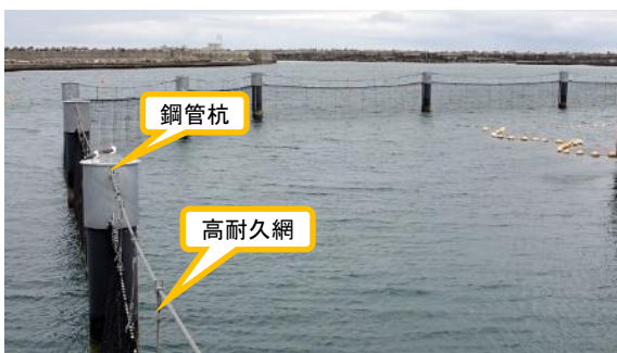
(写真 3) 東波除堤魚類移動防止網の設置状況
