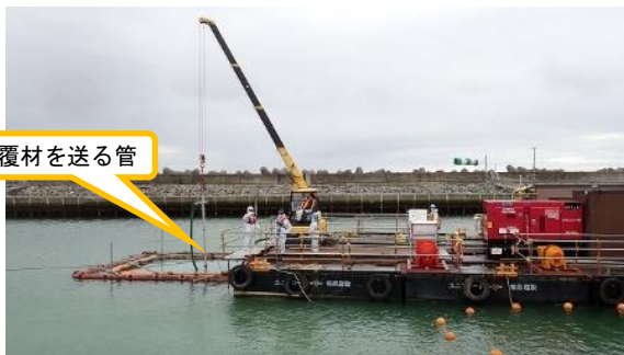
(写真 1) ユニフロート台船を使った施工状況
