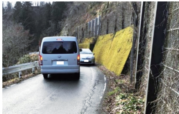
車両のすれ違いが困難な箇所
