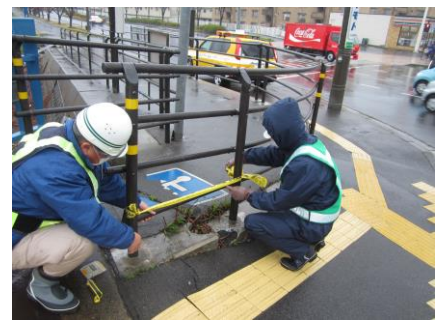
応急補修作業
