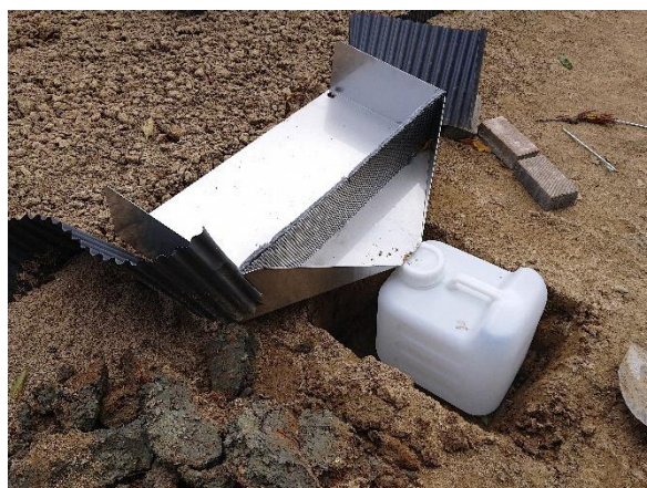
図4 土壌回収マスの設置状況
