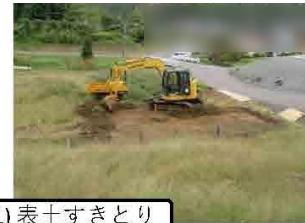
1) 表土すきとり
