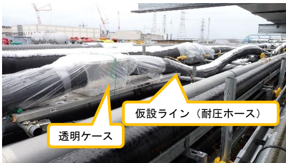
(写真6) 仮設ライン (耐圧ホース) の状況
