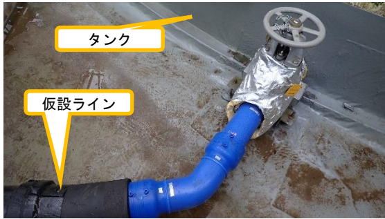
(写真3-1) J4タンクエリアの状況
