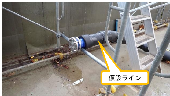
(写真3-2) J4タンクエリアの状況
