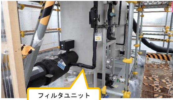
(写真5-2) フィルタユニットの状況
