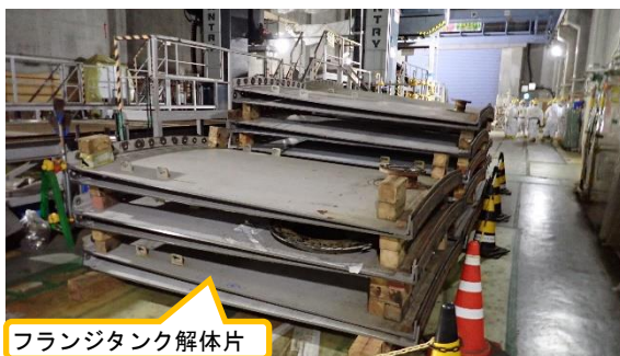
(写真4-2) 切断されたフランジタンク解体片の 仮置状況
