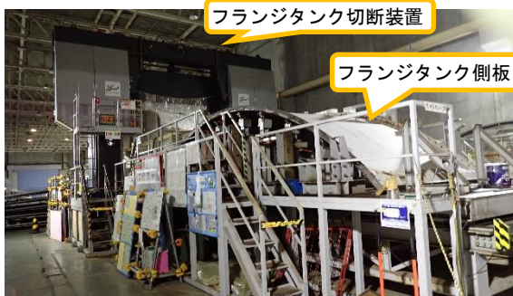
(写真4-1) フランジタンク切断装置の設置状況
