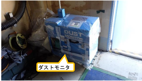
(写真3) 倉庫内におけるダストモニタの設置 状況
