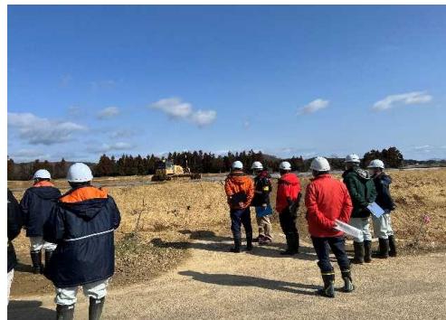
【水田整地工事現場の点検状況（三穂田北部地区）】
