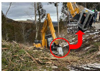
【マルチャーを装着した建設機械】
