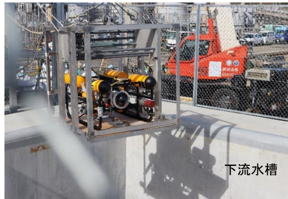
水中ROV投入状況
