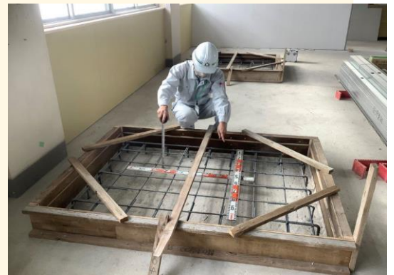
↑ 現場での検査の様子
