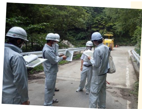
↑林道事業に関する現地調査
