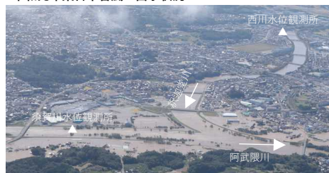
令和元年東日本台風の出水状況
