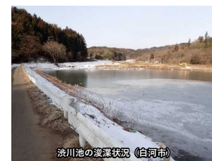
農業用ため池の治水整備
