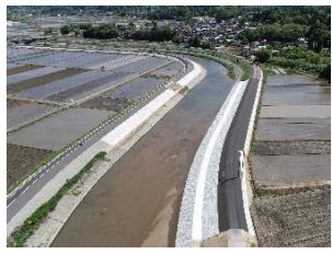
河川改修・河道掘削
