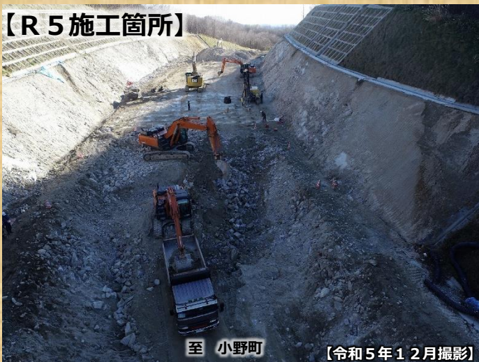
【施工状況（岩の掘削工事）】
