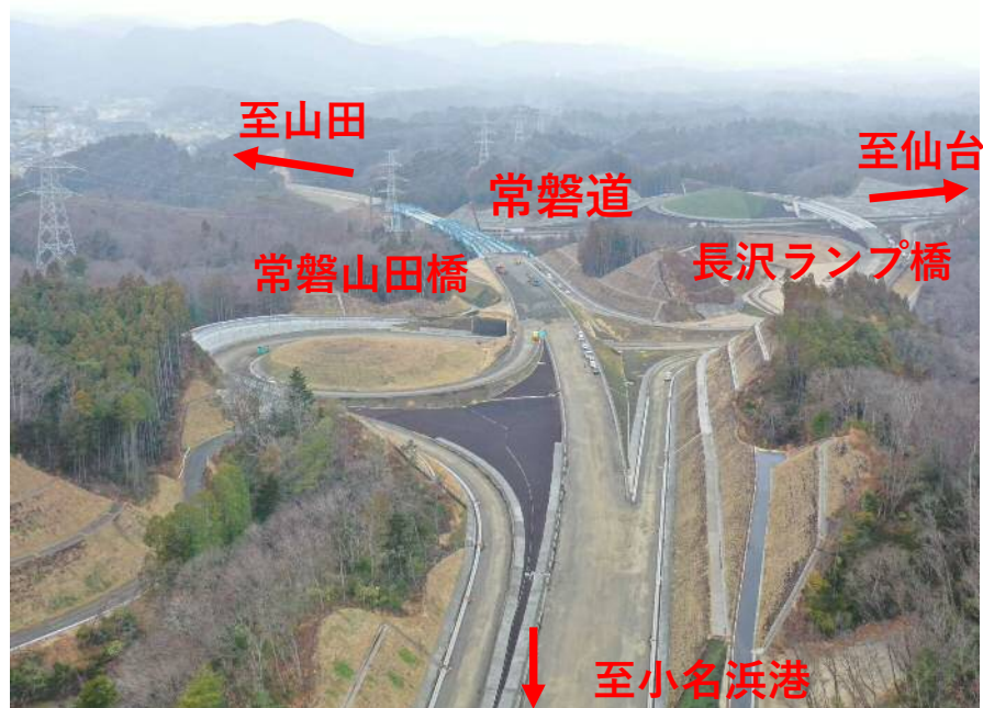
【写真⑩】 山田町地内（（仮称）いわき小名浜IC）
