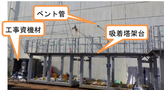
(写真 1 - 1) 高温焼却炉建屋東側の状況(2月8日撮影)
