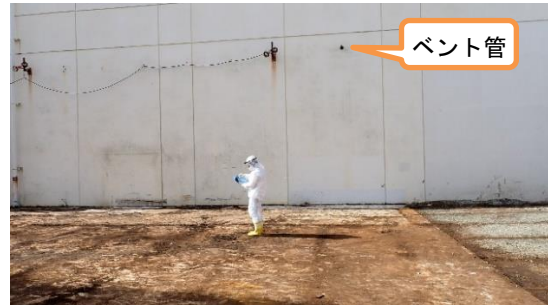
(写真 1 - 2) 高温焼却炉建屋東側の状況(2月9日撮影)
