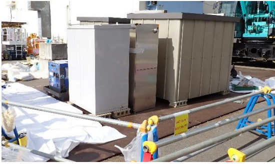
(写真4) 高温焼却炉建屋南東側に仮置かれていた工事資機材。
