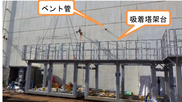
(写真 4-2) 高温焼却炉建屋東側に保管されていた吸着塔架台の状況(2月8日撮影)
