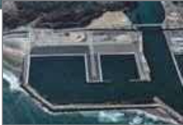
松川浦漁港の復旧状況【令和2年度全建賞受賞】
