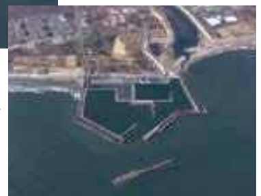
請戸漁港の復旧状況【令和4年度全建賞受賞】
