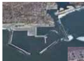
被災直後 (平成23年9月)
