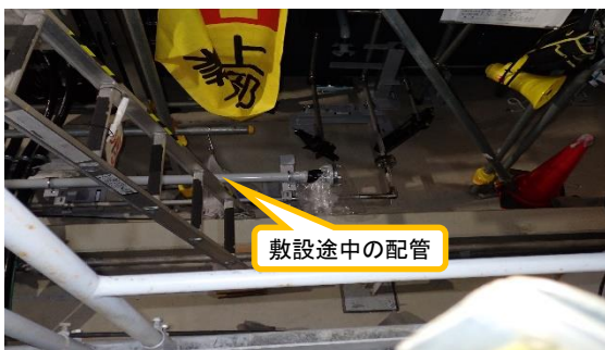
(写真6-3) 増設ALPS (A系) の前処理設備 改造工事の状況③ (北側から撮影)
