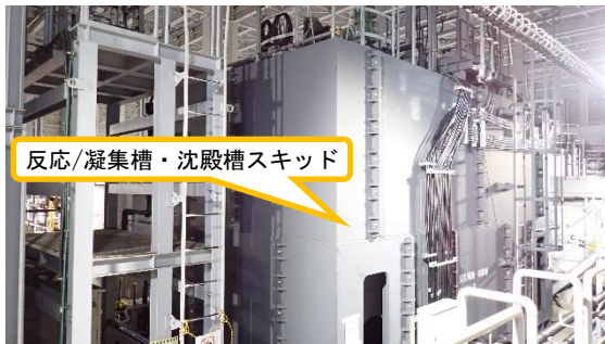
(写真5-1) 増設ALPS (C系) の前処理設備 改造工事の状況① (北東側から撮影)
