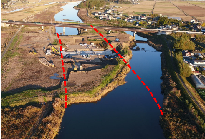
①施工状況（宇多川）
