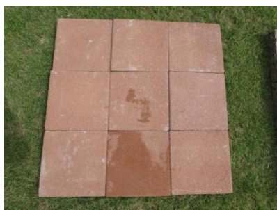
図-1 透水平板設置状況
