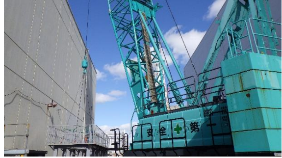
(写真 3-2) 高温焼却炉建屋東側でのクレーンの状況(2月8日撮影)
