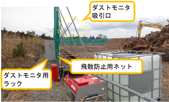
(写真 3 - 1) 飛散防止用ネット及びダストモニタ の設置状況
