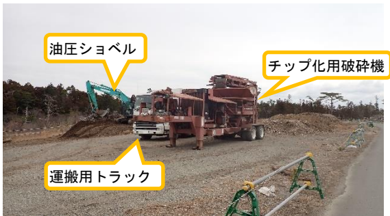
(写真1-3) 重機等の配備状況②
