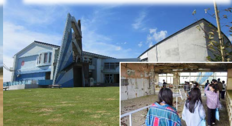
震災遺構浪江町立請戸小学校
