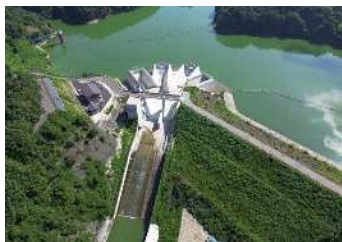
千五沢ダム再開発事業（一級河川北須川）
