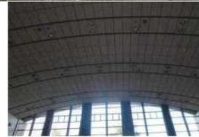
体育館の耐震改修
