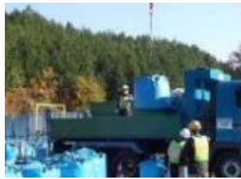
除去土壌等の車両積込状況
