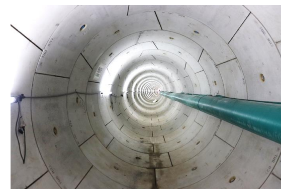
放水トンネル内
