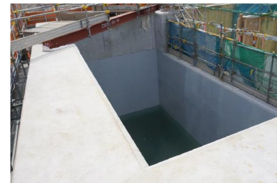
放水立坑（下流水槽）
