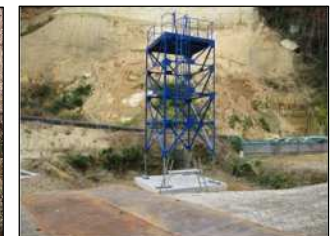
【復旧工事中】 （橋脚が完成）
