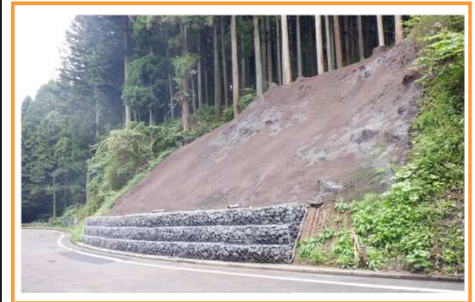
被災した林道法面の復旧
