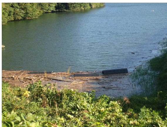
四時ダム 流木状況
