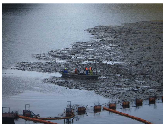
高柴ダム 流木処理状況
