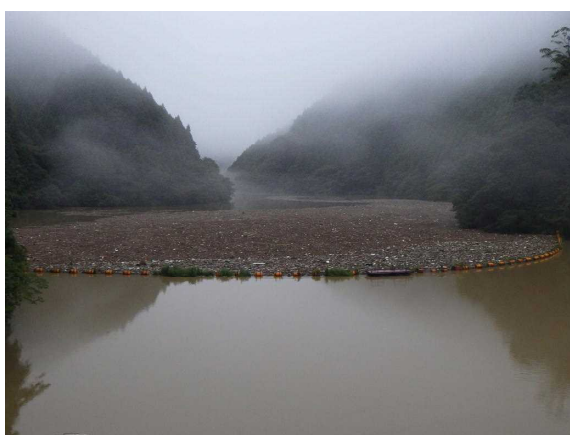
高柴ダム 流木状況
