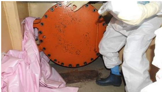
(写真4-1) 5号機X-6ペネ① ・扉開放前の状況 (PCV外側から撮影)
