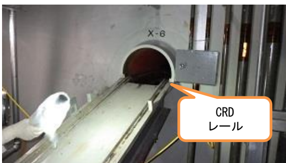
(写真4-3) 5号機X-6ペネ③ ・PCV内側の状況
