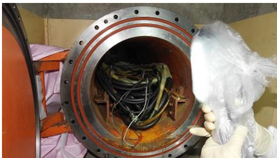
(写真4-2) 5号機X-6ペネ② ・扉開放後の状況 (PCV外側から撮影)
