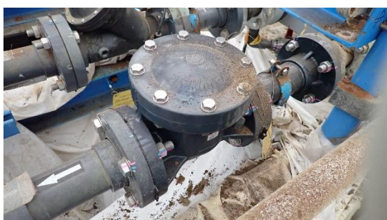
(写真2-1) 交換した弁の状況
