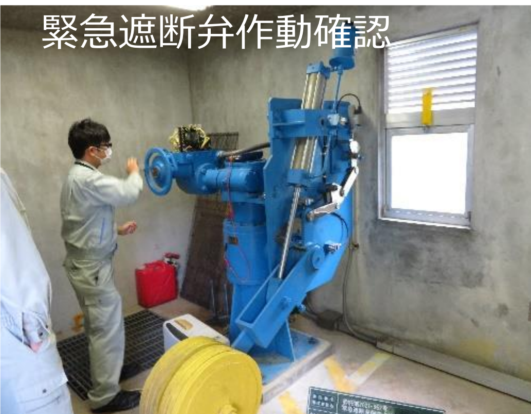
制水弁作動確認状況(導水管)
