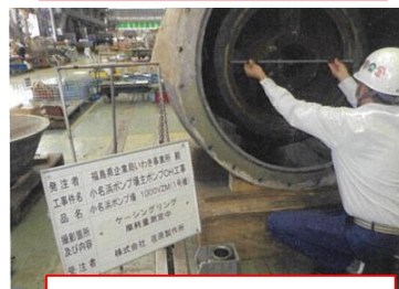
分解・点検状況
