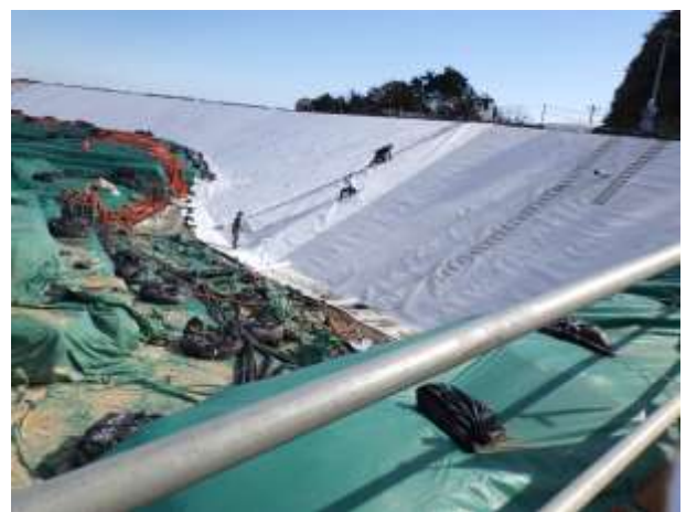
土堰堤遮水工の状況
