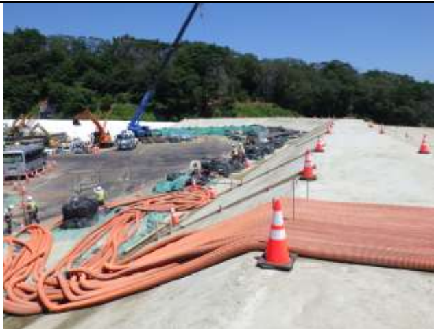
雨水の排除状況
