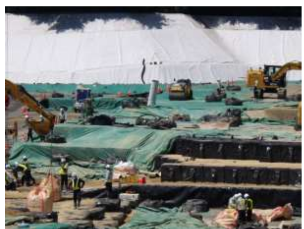
縦管の施工状況
