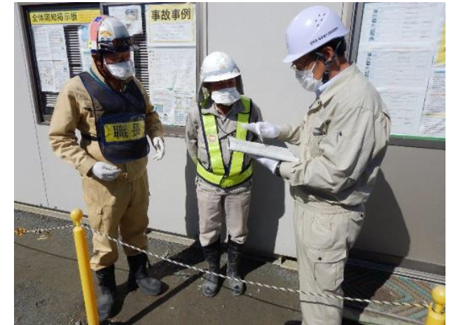
発注者安全点検
