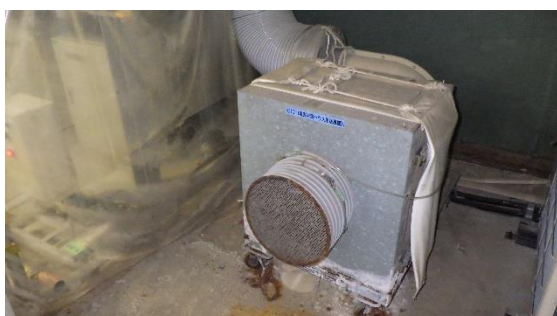
(写真1-1) 塩害対策ハウス用送風機
