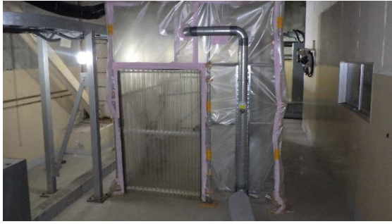
(写真3-1) ハウス外観（仮設局所排気設備）
