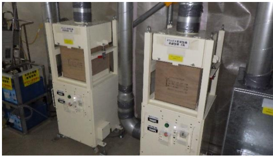
(写真3-2) フィルタ付き仮設局所排気設備（仮設局所排気設備）
