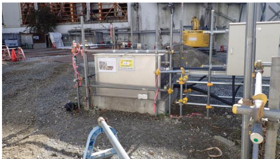
(写真3-3) サブドレンピットNo.211の状況 (北側から撮影)
