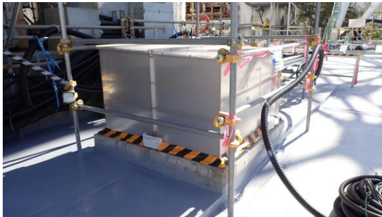
(写真3-2) サブドレンピットNo.210の状況 (北西側から撮影)
