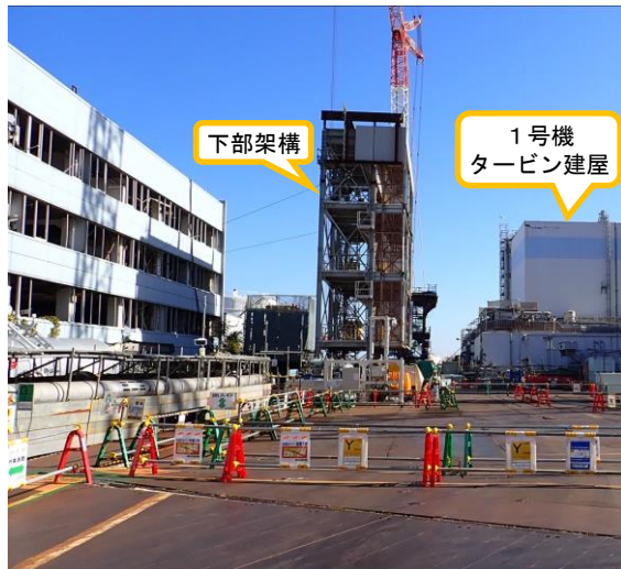
(写真1-3) 1号機原子炉建屋北側ヤードの状況 (西側から撮影)
