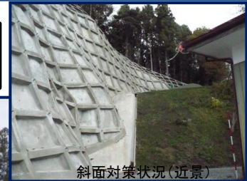
斜面对策状況(近景)
