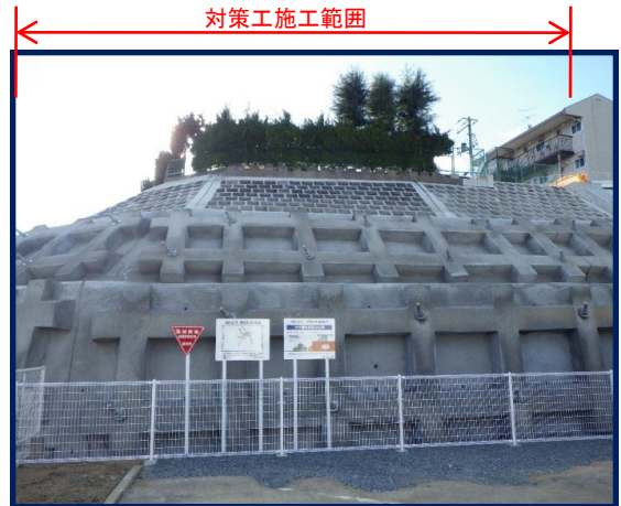
工事完成(平成25年12月)
